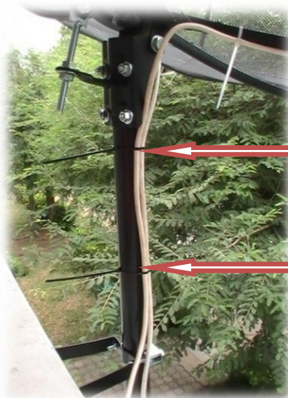
ภาพ 27 แสดงการเก็บสายนำสัญญาณ RG-6 ที่เสา ที่มา: นายมานพ แสงสว่าง
