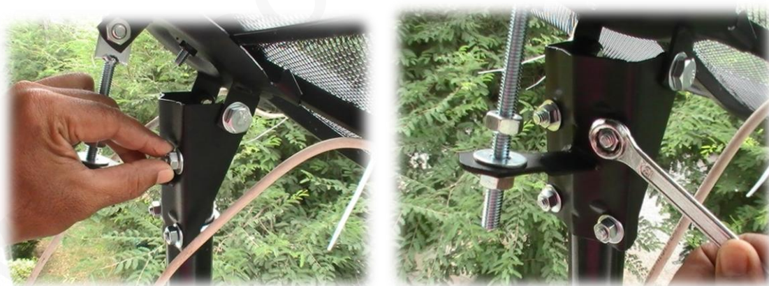
ภาพ 11 แสดงการขันน็อตที่คองานแน่นพอประมาณ ที่มา: นายมานพ แสงสว่าง
