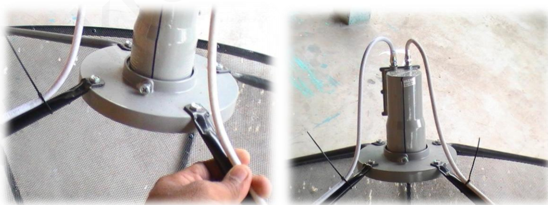
ภาพ 7 แสดงการไค้และรัดสายนำสัญญาณ RG- 6 ด้วยสายรัดพลาสติก (Cable tie)
