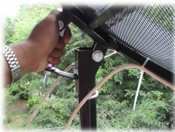
ภาพ 10 แสดงการยกงานขึ้นไปสวมที่เสา ที่มา: นายมานพ แสงสว่าง
